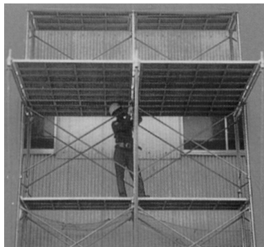
梁材と斜材の取付金具のカブラを本締め
